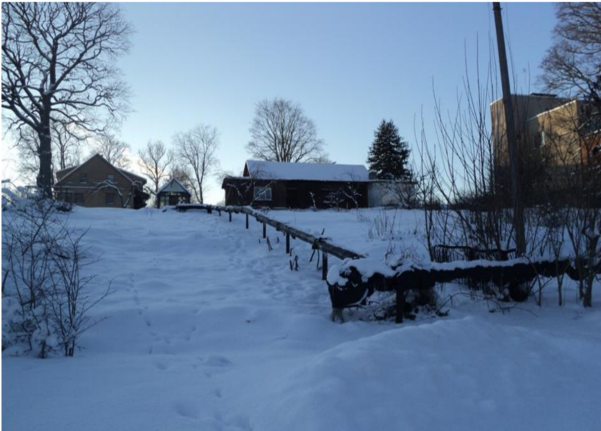
Joonis 2. Kasutusel on ka maapealseid torustikke. Sauna minev torustik.
