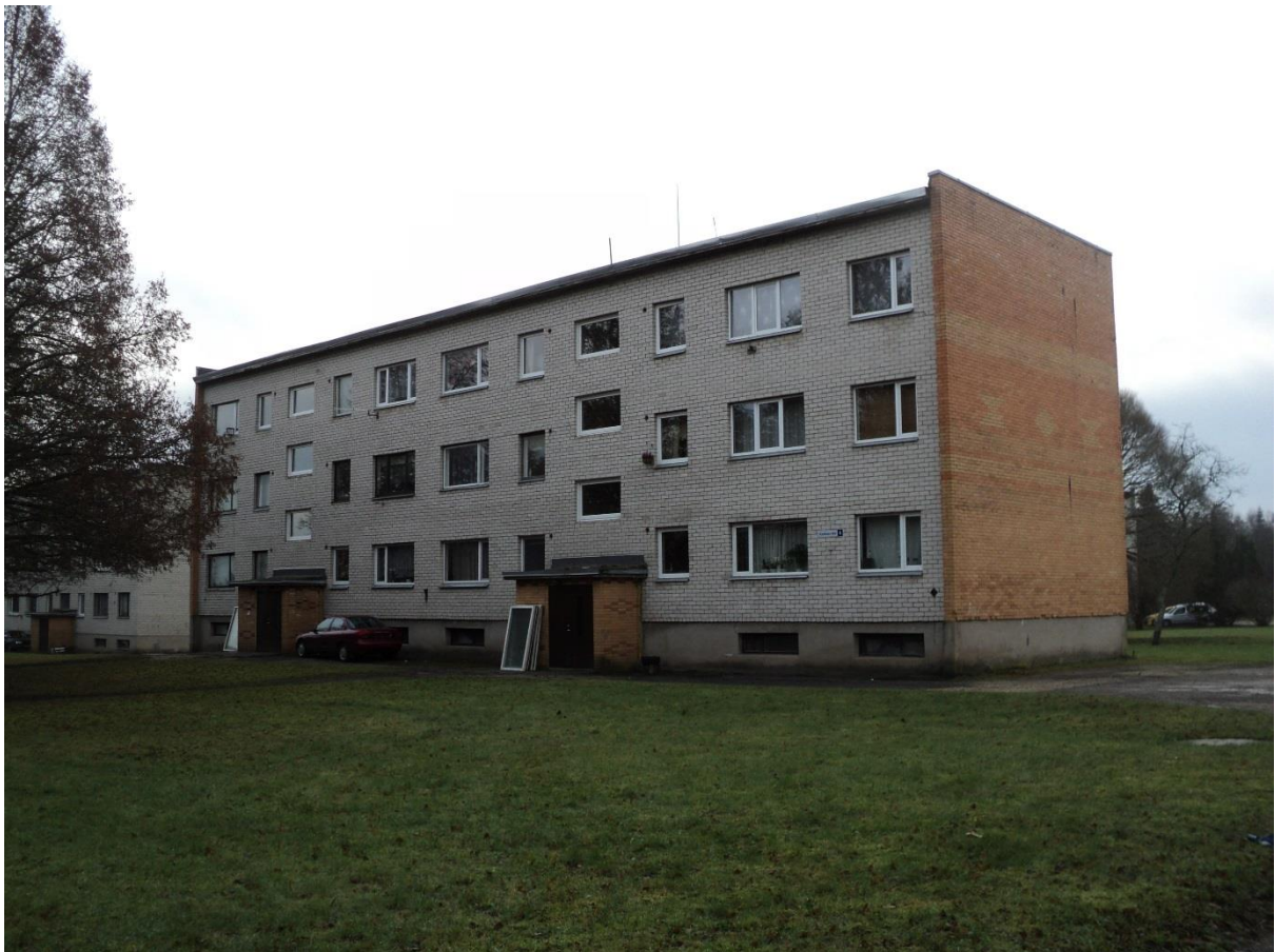
Joonis 5 . Näide tüüpsest elamust, mida nagu näha pole komplekselt renoveeritud, kui akende vahetuski oli pildistamise ajal pooleli.
