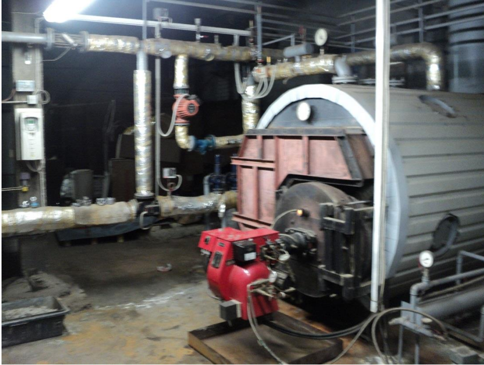
Joonis 1 . Vaade olevasse põlevkiviõlil töötavasse katlamajja.
