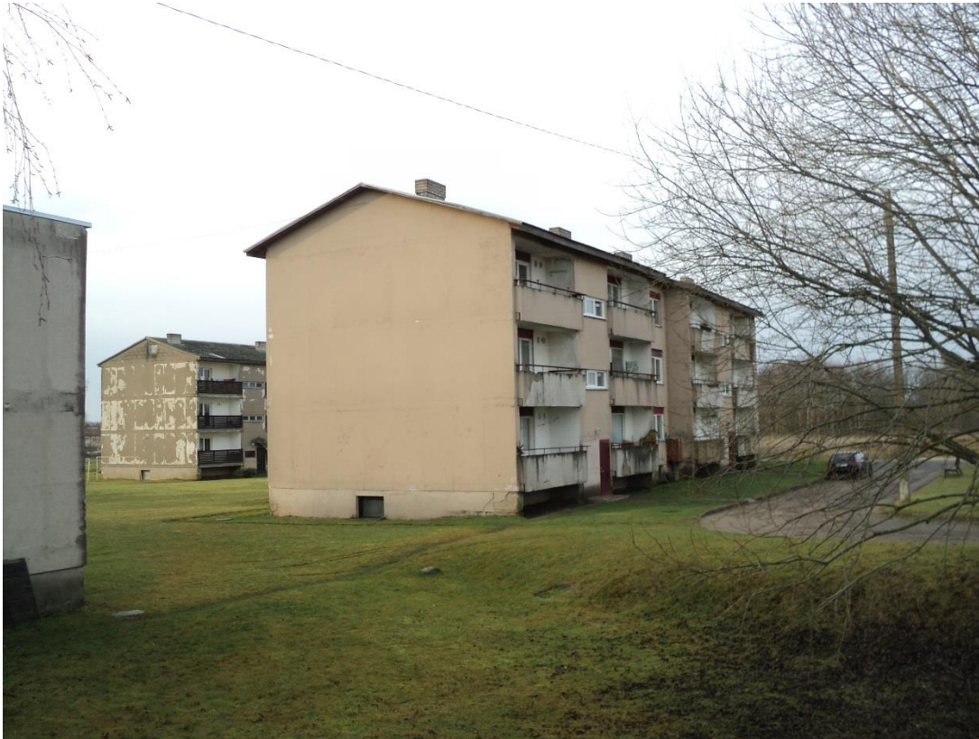
Joonis 7 . Elamud Päre tee 12 ja taamal Pihlaka tee 1. Elamud on soojustamata.
