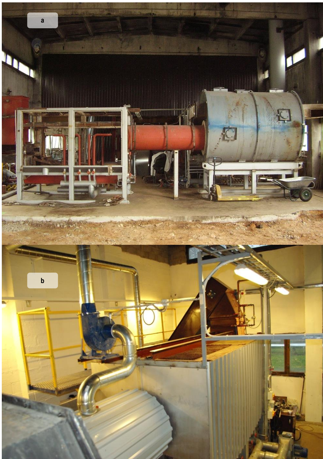
Joonis 3.1.1 – a). Mustla katlamaja ümberehitus, b). hakkepuidukatel
